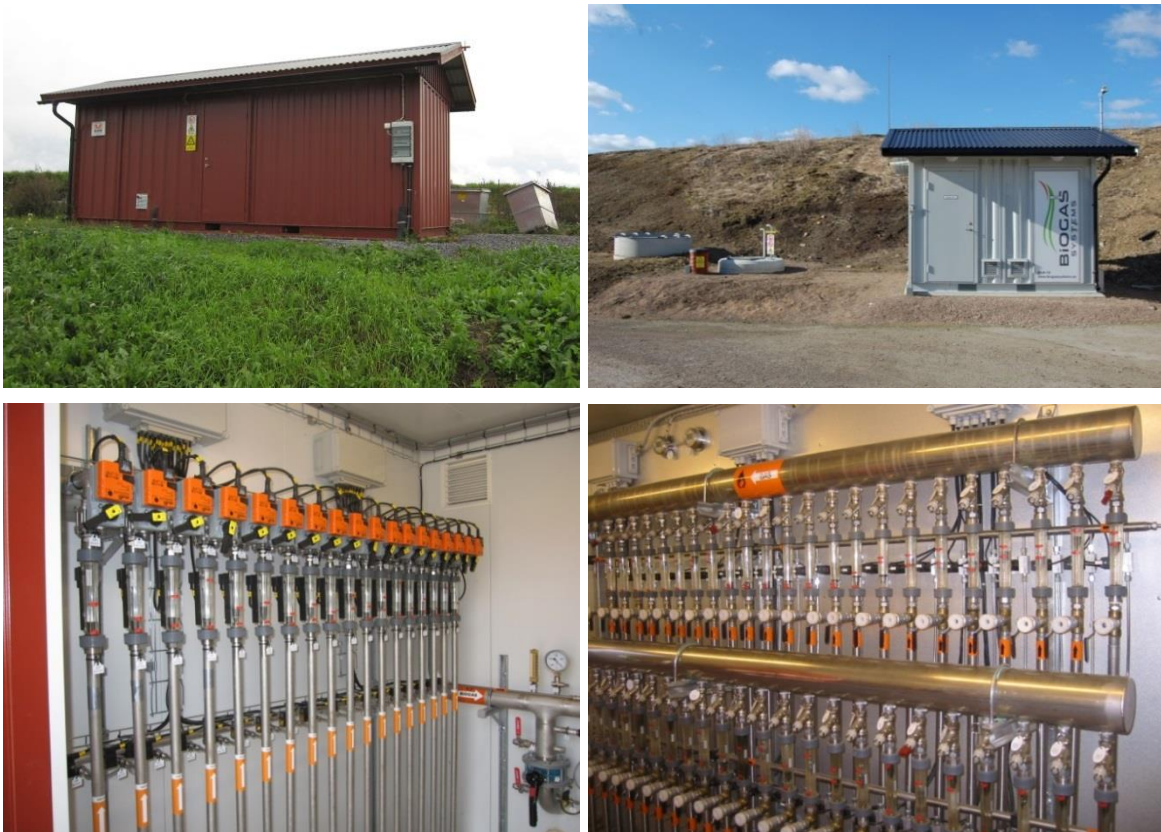
Figur 7-11. Urval av reglerstationer (Övre vänster: Lilla Nyby i Eskilstuna (Serti, 2010). Övre vänster: Filborna i Helsingborg (Rosqvist, 2013) och regulatorer, insidan av en reglerstation (Nedre vänster: Vafab i Västerås. Nedre höger: Tveta i Södertälje. (Serti, 2012, 2003).
