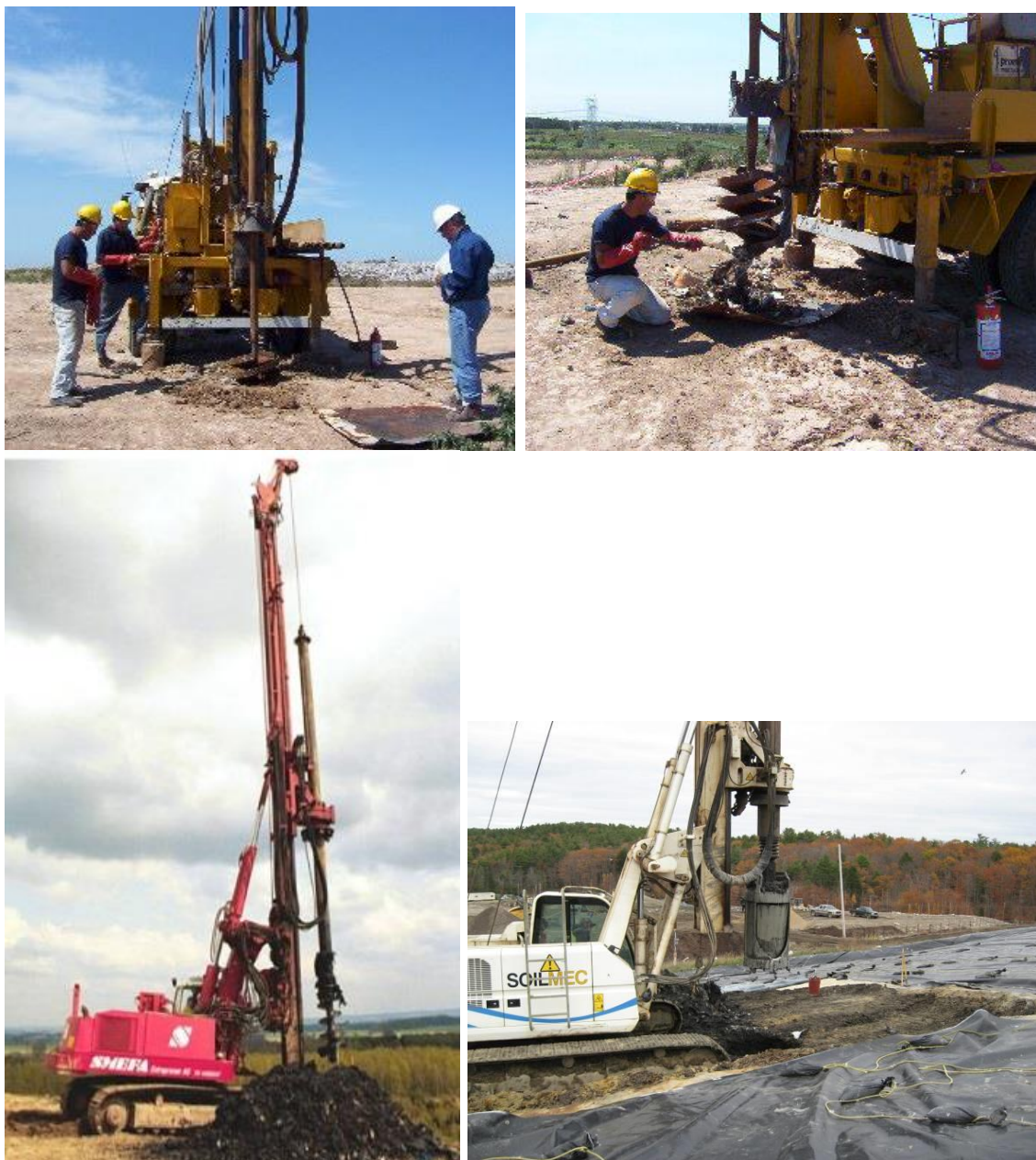
Figur 7-4. Olika borrhörtekniken för etablering av vertikal gasbrunnar. Skruvborrning: övre höger och vänster samt nedre vänster. Kärnborrning: nedre höger. (Landfill Gas Management System & Landfill Gas-To-Energy Project, 2013).
