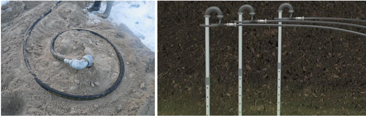
Figur 7-9. Gasbrunn med inkopplad uttagsledning (Biogas Systems AB, 2013).
