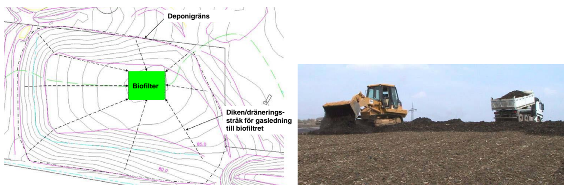
Figur 7-18. Vänster: metanoxiderande skikt koncentrerat till ett område på deponin (Serti, 2013). Höger: utläggning av metanoxiderade skikt bestående av kompost över en hel deponi som saknar tätskikt (UN, 2011).
