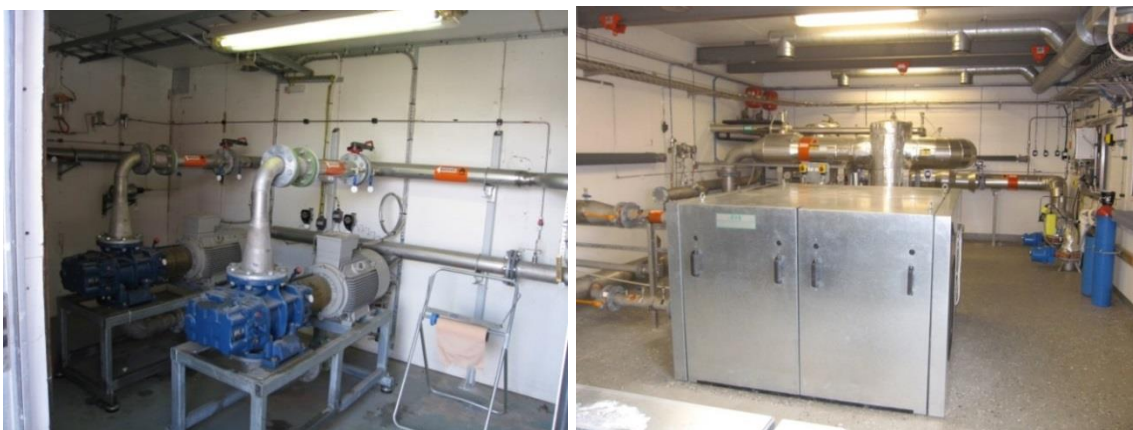
Figur 7-15. Pump-/kompressorstation (Vänster: Lilla Nyby i Eskilstuna (Serti, 2008). Höger: Vafab i Västerås, 2012)). Notera de inkapslade/ljudisolerade kompressorerna i det högra fotot.
