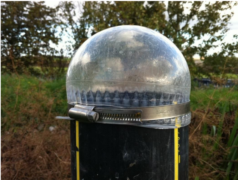
Figur 6-2. Konstaterande av ett tydligt gastryck med hjälp av en silikonhatt som anbringats på ett grundvattenrör på Albäcksdeponin i Trelleborg, Sysav (Foto: Staffan Salö, Sysav Utveckling AB).
