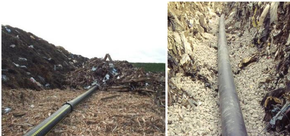
Figur 7-8. Horisontella gasdräner (Referens till vänstra bilden: NSR Helsingborg. Referens till högra bilden: Townsend, 2007).
