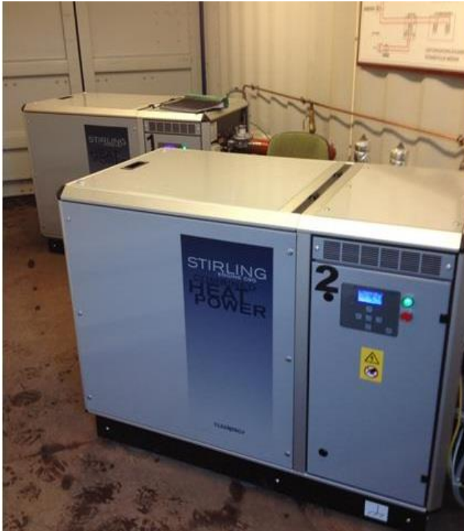
Figur 8-4 .Stirlingmotorer på Rönneholmsanläggningen (MERAB 2012).
