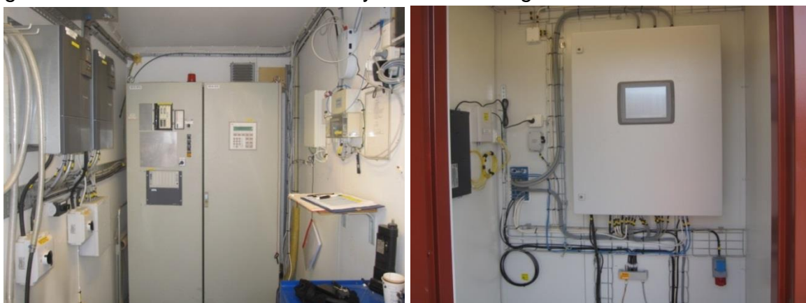
Figur 7-13. Illustration av automatiska övervakningssystem för deponigas (Höger: Lilla Ny by i Eskilstuna (Serti, 2013). Vänster: Vafab i Västerås (Serti, 2012)).
