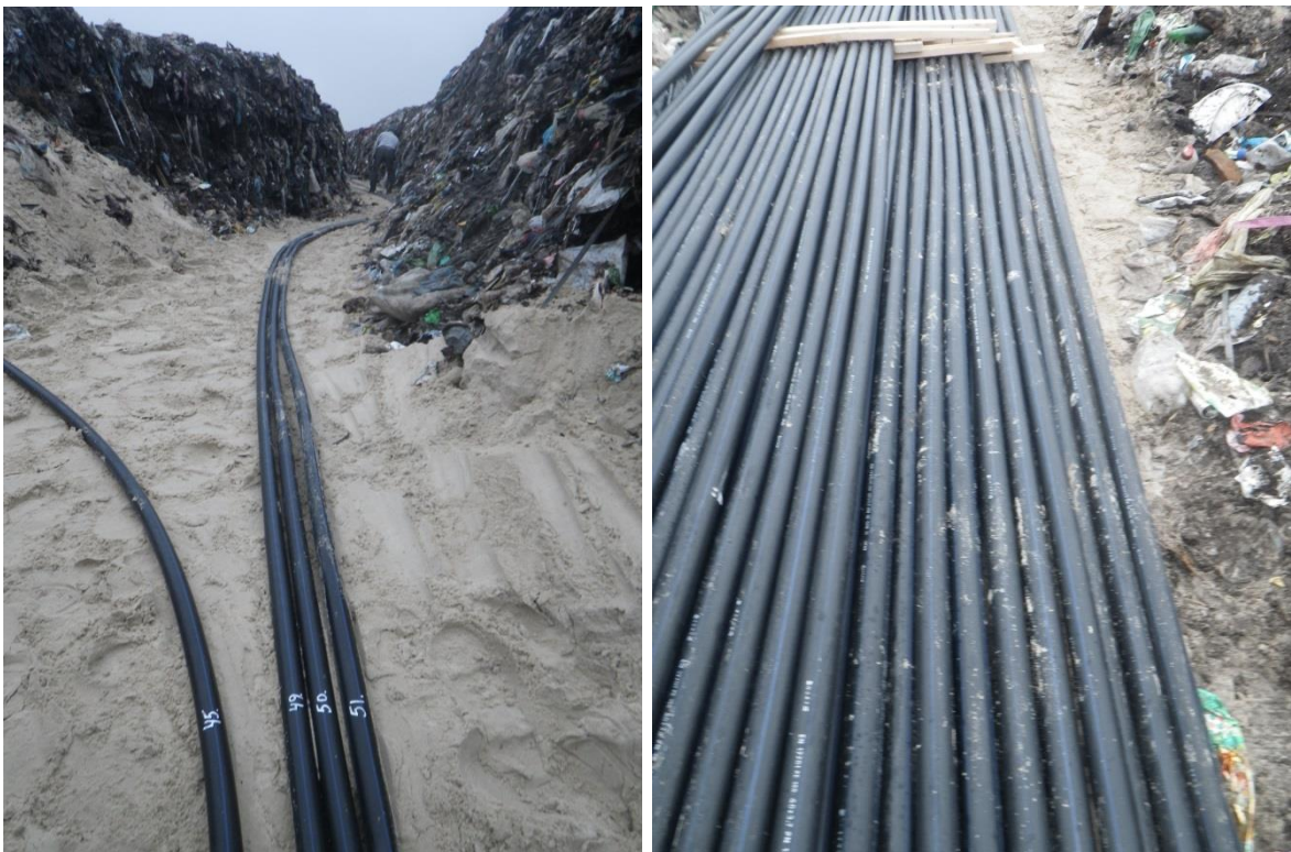
Figur 7-10. Gasuttagsledningar i gemensamma ledningsstråk/-dike (Biogas Systems AB, 2013).
