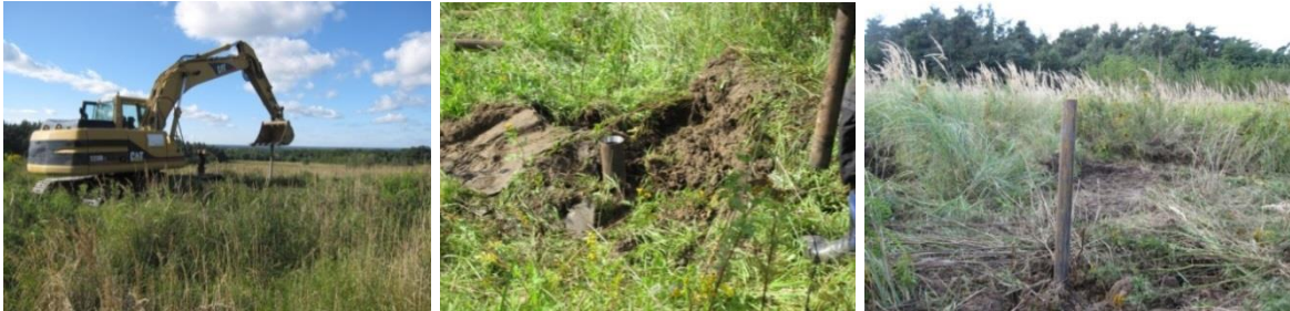
Figur 7-6. Spetsade perforerade stålrör som tryck med grävmaskin ner i deponin (Serti, 2010).
