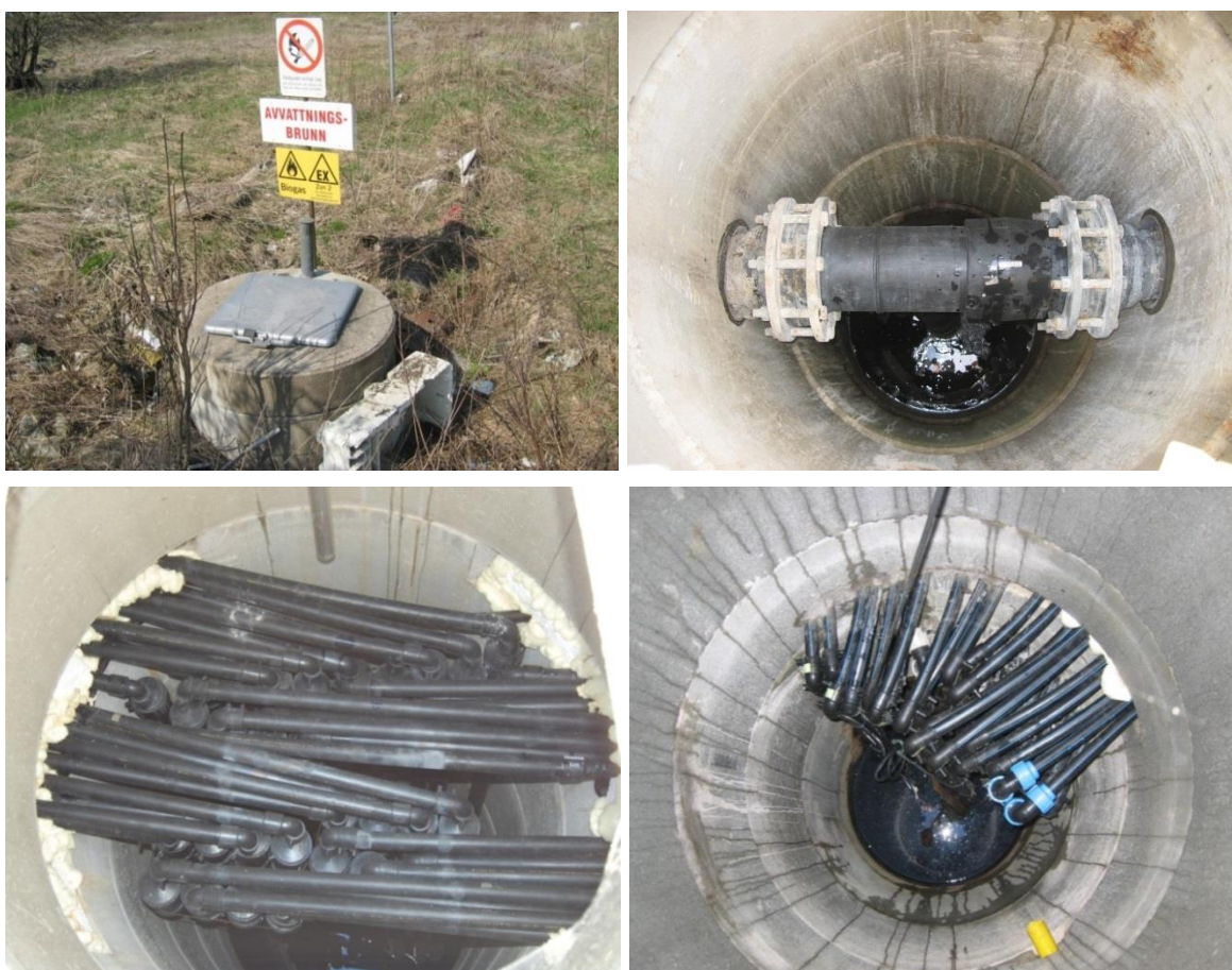
Figur 7-14. Urval av Kondensatbrunnar (Övre vänster och höger: Lilla Nyby i Eskilstuna (Eskilstuna Energi och Miljö AB, 2005)). Nedre vänster: Filborna i Helsingborg (Rosqvist, 2013). Nedre höger: Högbytorp i Upplands-Bro (Serti, 2005)),
