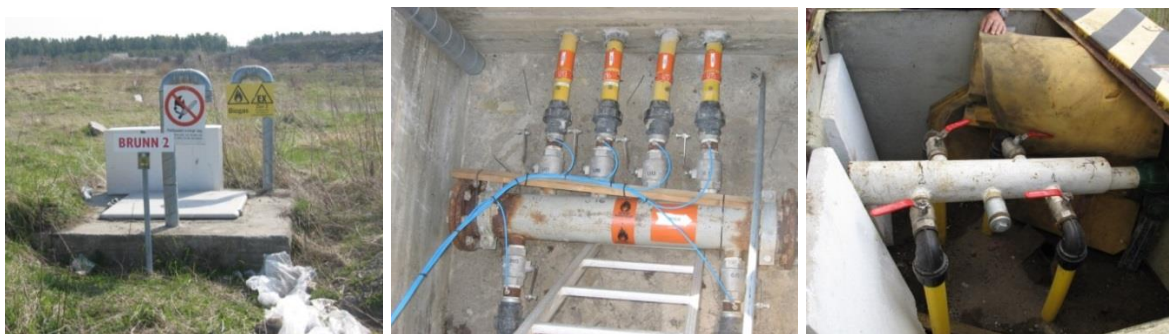
Figur 7-12. Illustration av reglerbrunnar (Höger och mitten: Lilla Nyby i Eskilstuna (Eskilstuna Energi och Miljö AB, 2005). Vänster: Szczecin i Polen (Serti, 2010)).
